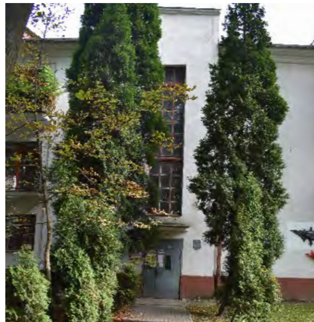
Фрагмент главного фасада
