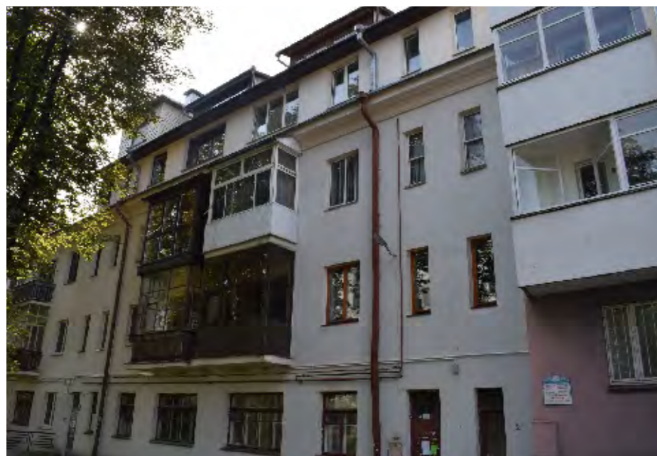
Фрагмент дворового фасада
